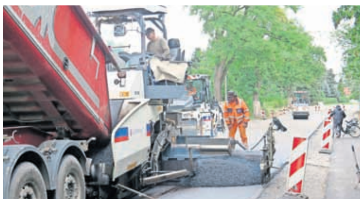
Die Asphaltarbeiten an der B102 in Treuenbrietzen sind schneller abgeschlossen als geplant.
